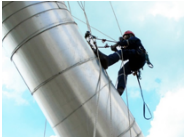
เทคนิคการโรยตัวด้วยเชือกเพื่อการตรวจสอบและซ่อมบำรุง (Rope Access)
